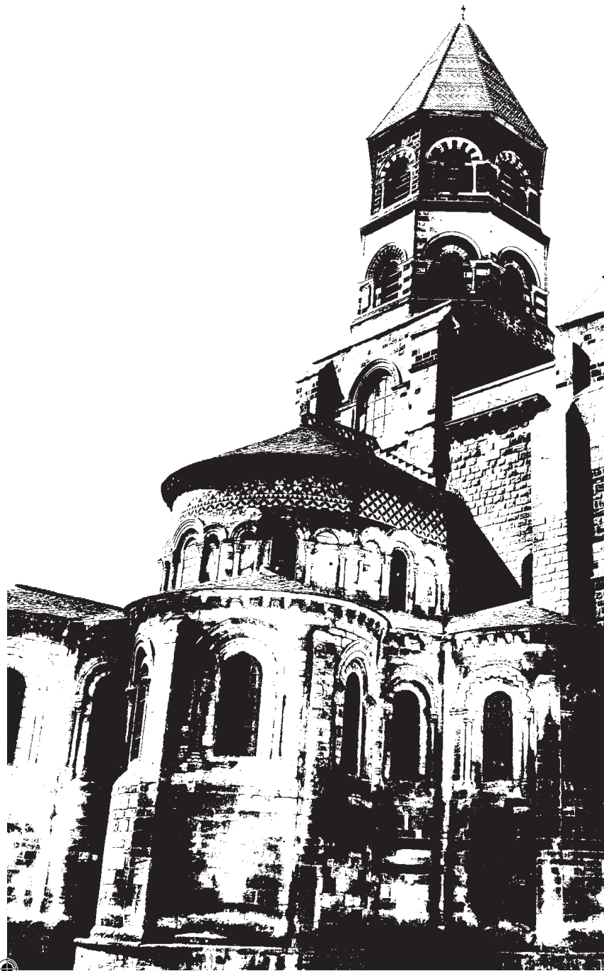
BASILIQUE SAINT-JULIEN - BRIOUDE. Plus grande église romane auvergnate, elle fut édifée sur la tombe du martyr considéré comme le protecteur de l'Auvergne. Chef-d'œuvre architectural, elle se caractérise par l'étonnante polychromie de ses pierres et dallages et offrant un cadre de concert unique, magnifié par les récents vitraux contemporains du moine artiste coréen Kim en Joong.
